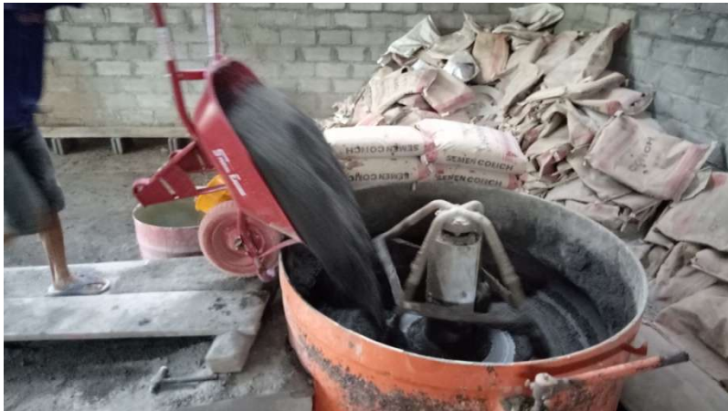
Gambar 8.5 Penuangan Pasir ke Mixer
