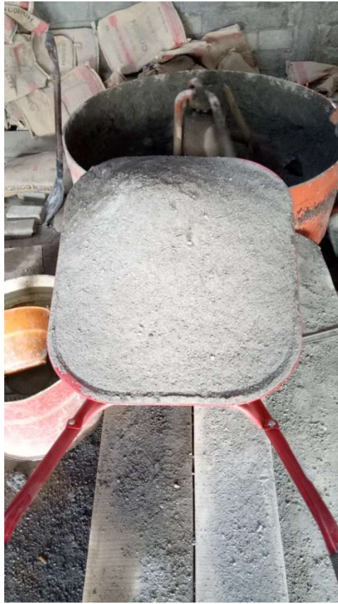
Gambar 8.5 Penuangan Pasir ke Mixer
