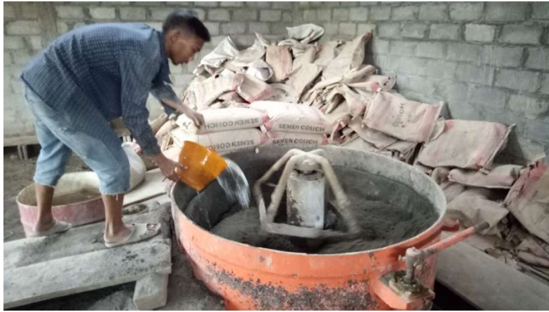
Gambar 8.9 Pemberian Air ke dalam Mixer
