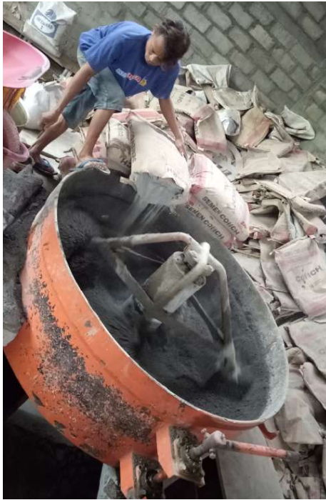
Gambar 8.7 Penuangan Semen ke dalam Mixer
