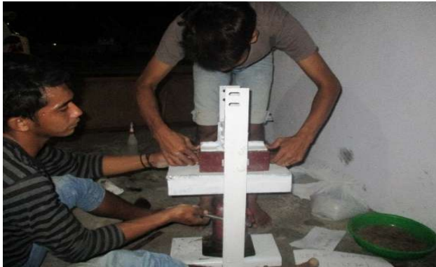
Gambar 4.11 Proses pembuatan Paving Block
